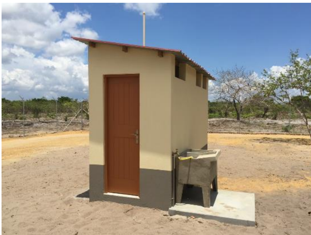
Figura 6-5: Latrina construída em Afungi como parte da parcela residencial modelo
